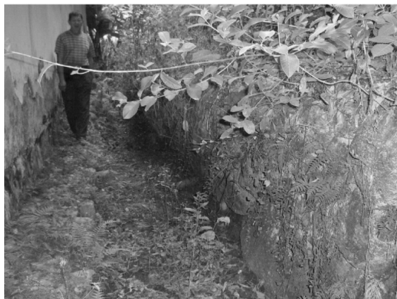
图 3 滑体前缘变形(房后挡墙外凸)
