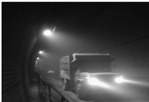
图2 隧道通风现状
